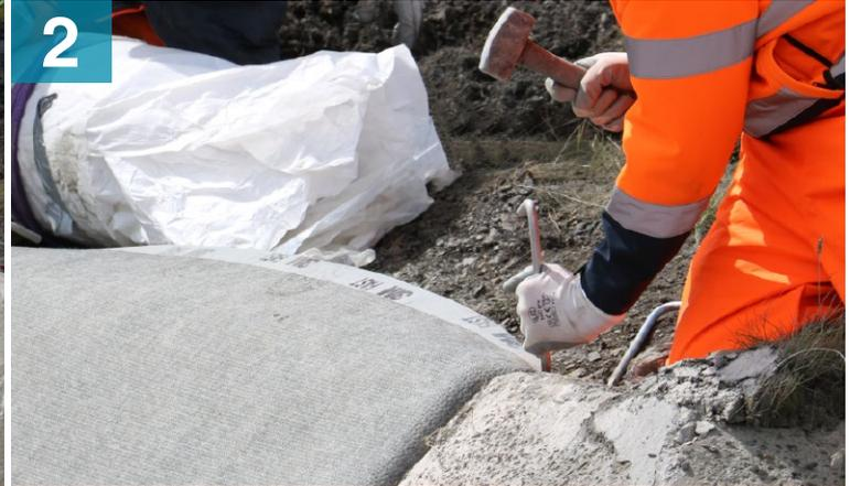
Fijación CCX™ dentro de las trincheras de anclaje
