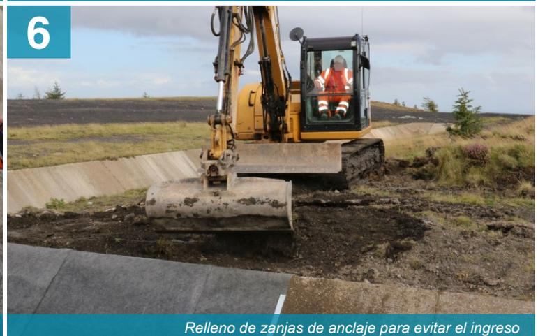
Relleno de zanjas de anclaje para evitar el ingreso
